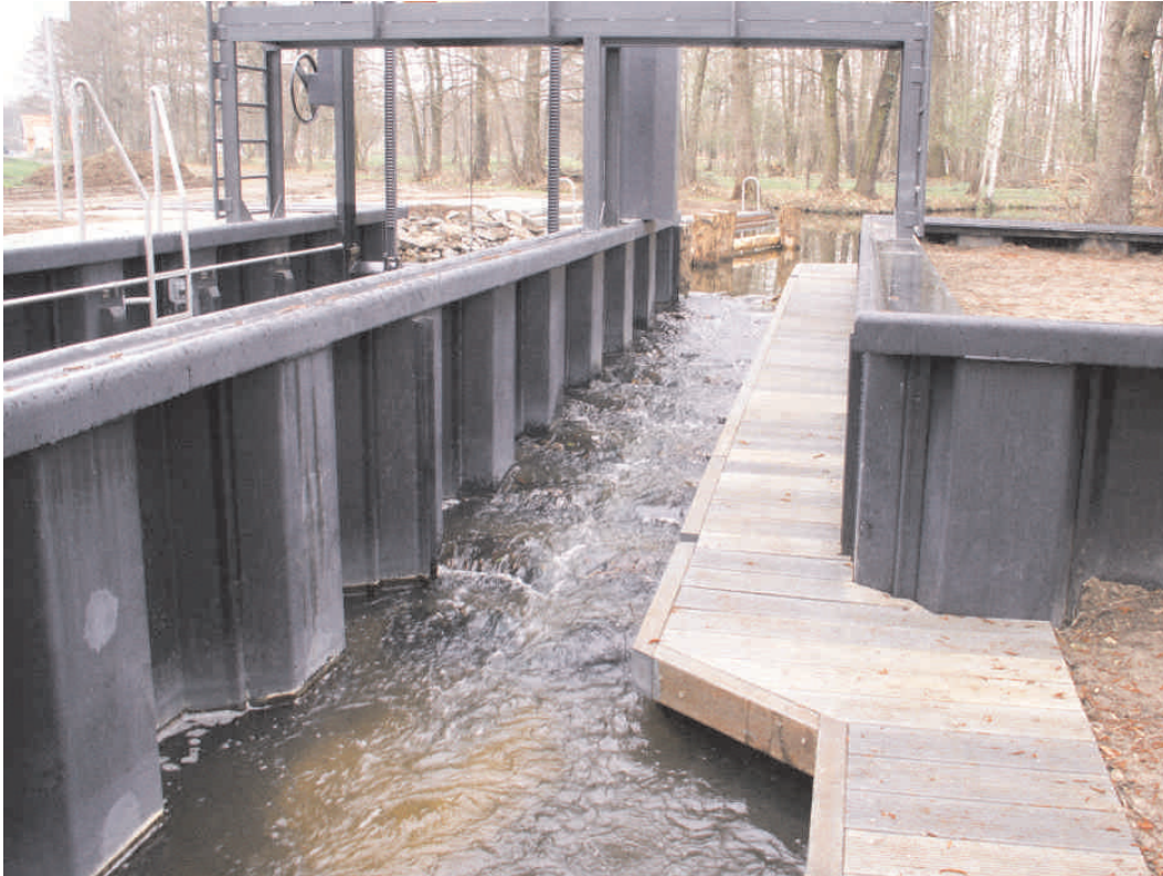
Abb. 2: Fisch-Kanu-Pass im Spreewald (am Wehr 21), Quelle: LKV Brandenburg e.V.
